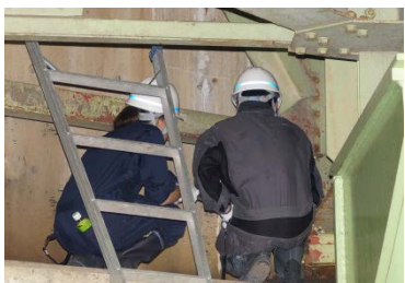
▲桁端部の腐食状況確認
