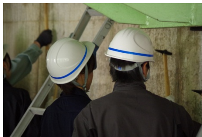
▲下部工の打音による点検状況
