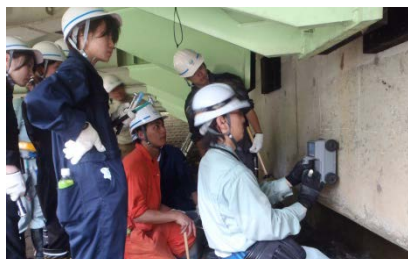
▲職員による鉄筋探查実演状況
