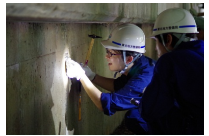
▲下部工のひび割れ幅測定状況
