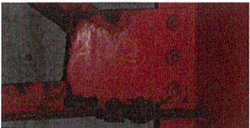
■桁端部及び支承に腐食が発生している。
