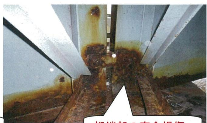
鋼橋、コンクリート橋及び下部工の損傷の殆どが、排水及び防水機能不良が原因となっています。
