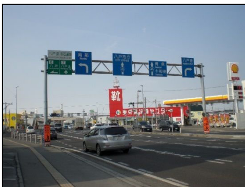
門型標識等（道路標識）
