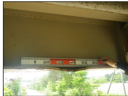
[横断歩道橋の変形（車両の接触痕）]
