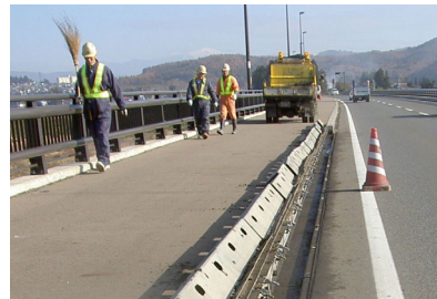
排水柵の清掃
