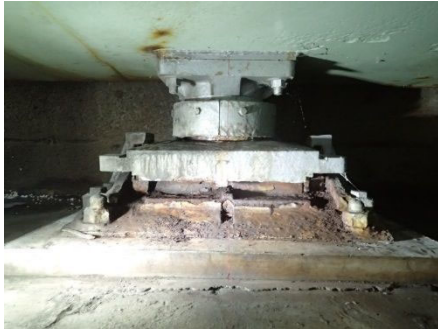
【損傷状況④】 機能障害、移動
