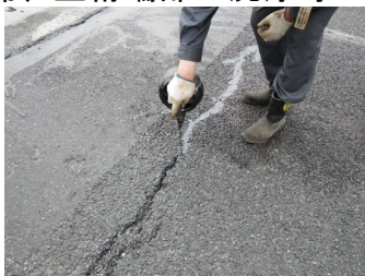
舗装のひびわれ補修 （シール材注入）
