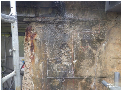
【損傷状況③】 縦壁の剥離・鉄筋露出、うき
