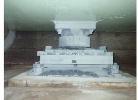
【対策事例④】 支承補修
