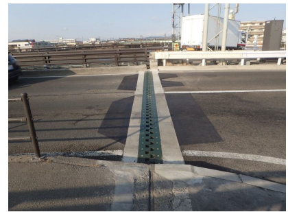
【対策事例⑤】 舗装補修
