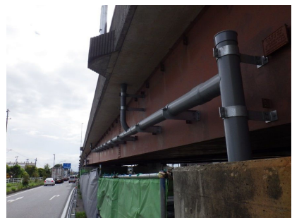
【対策事例⑥】 排水管の部材交換
