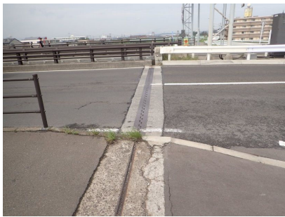
【損傷状況⑤】 舗装ひびわれ
