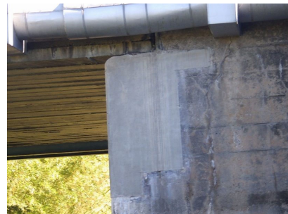
【対策事例③】 下部工の断面修復工
