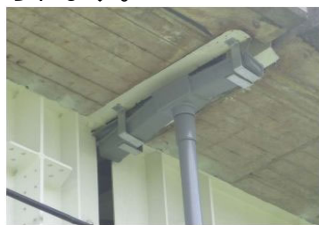
漏水部への 簡易樋の設置
