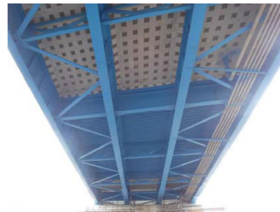
【対策事例②】 床版の部分打換+炭素繊維シート貼付
