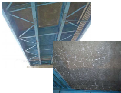
【損傷状況②】 ひびわれ(格子状)
