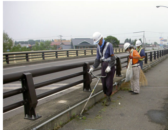
歩道部の除草
