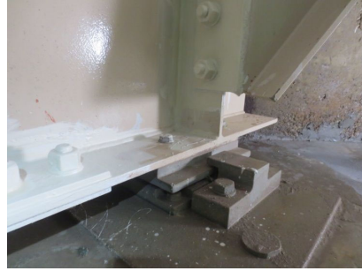
【対策事例①】 主桁補修
