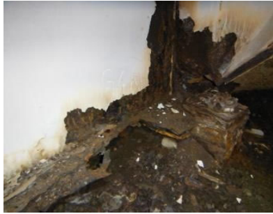
【損傷状況①】 断面欠損
