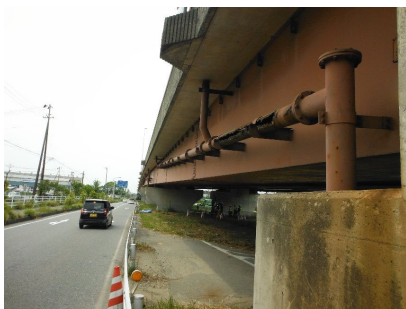
【損傷状況⑥】 腐食、欠損
