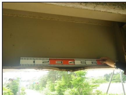
[横断歩道橋の変形（車両の接触痕）]
