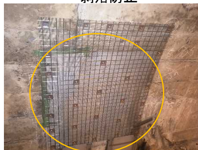
【対策事例②】 漏水対策
