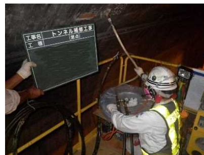
【対策事例③】 覆工背面空洞対策（注入工）
