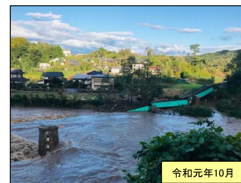
【第六久慈川橋梁(JR東日本 水郡線)】
