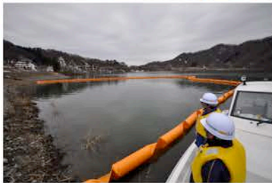
↑湖岸でオイルフェンスを連結しボートで移動しながら、湖面に100mのオイルフェンスを設置。
