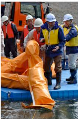
↑湖岸でオイルフェンスを連結しボートで移動しながら、湖面に100mのオイルフェンスを設置。
