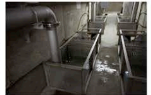
監査廊内 浸透流測定室 ↑
