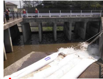
吸水槽河川水貯留状況
