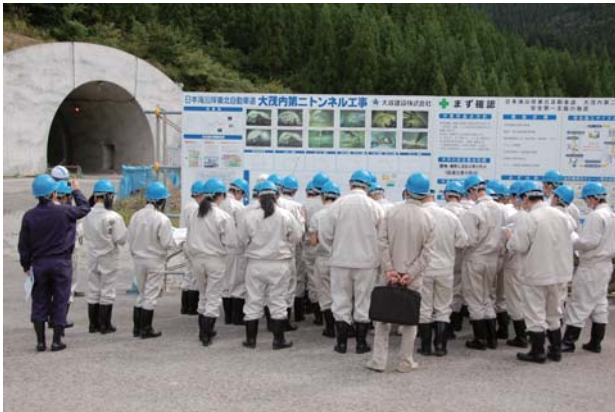
【トンネルの概要について】
