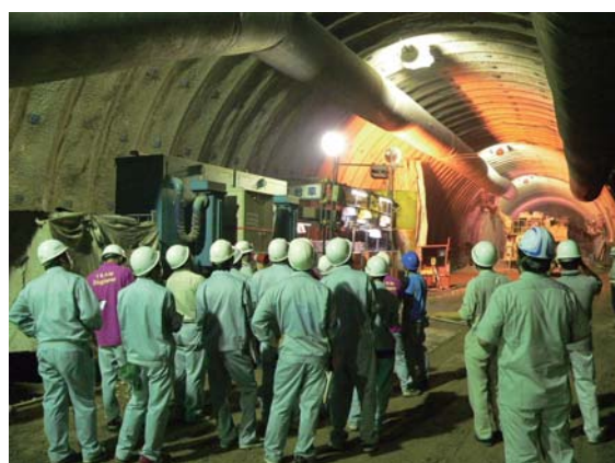
【順調に掘削が進んでいます】
