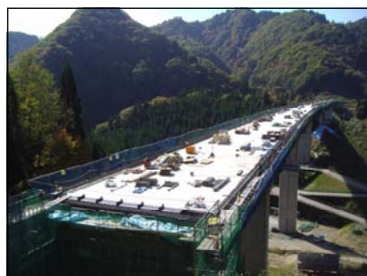
(床版施工状況・H20.10)
