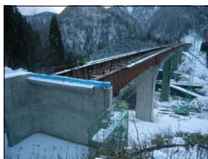
(桁連結完了・H19.12)
