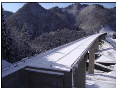
(上部工完成・H20.12)
