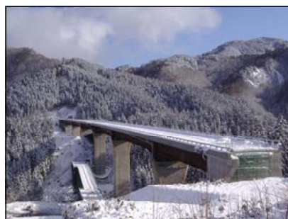
(上部工完成・H20.12)
