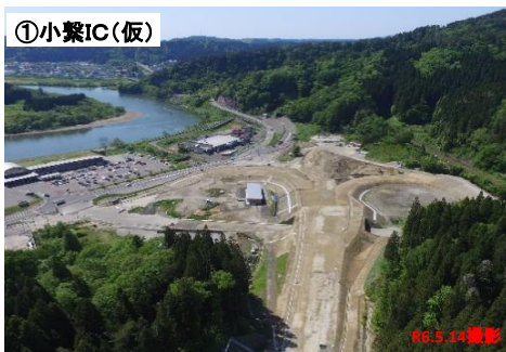
②函渠工～今泉第二トンネル(仮)側
