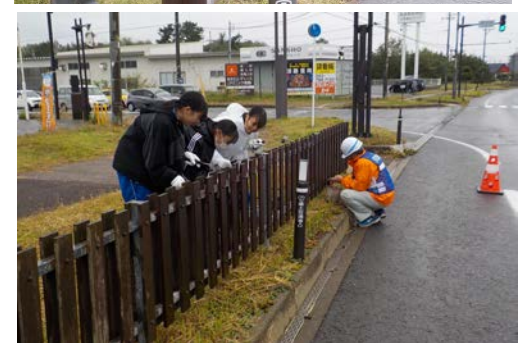
塗装作業の様子
