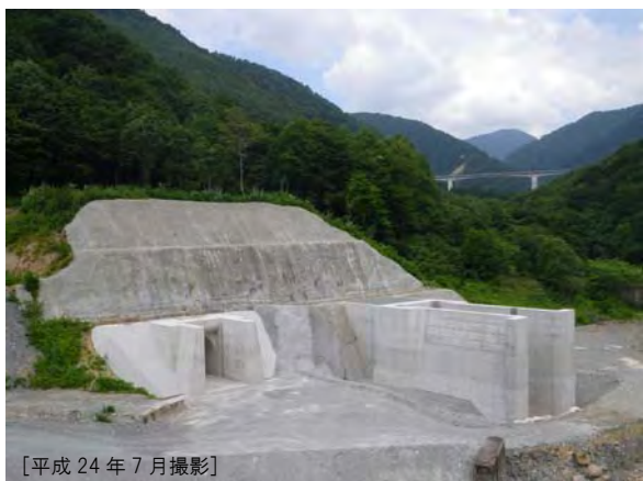
転流工施工状況
