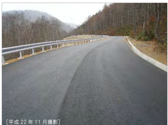
上流迂回道路
