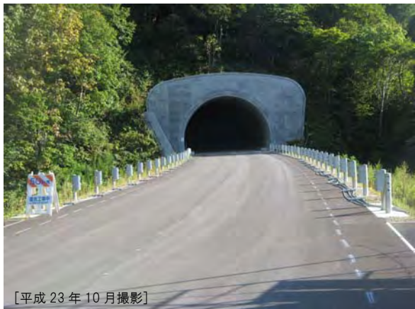
付替国道 1 号トンネル
