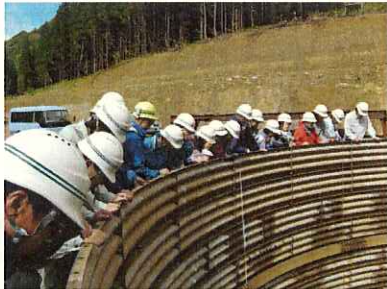
（1号橋下部工現場でP2深礎杭を覗いている）
