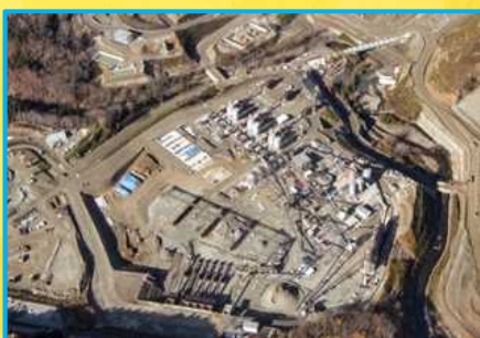
製造プラント(令和元年11月撮影)
