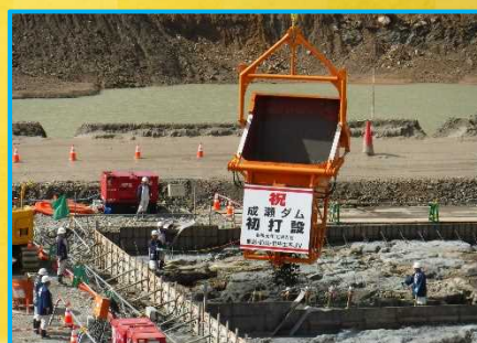
コンクリート打設式(令和元年10月撮影)
