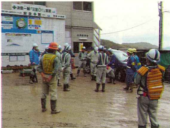
(1号トンネル工事パトロール状況)
