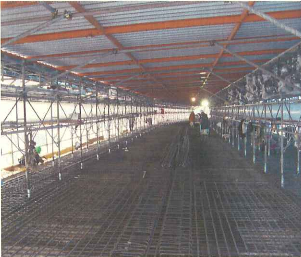
(仮囲い内 鉄筋配筋状況)
