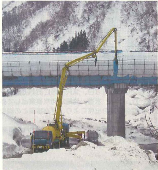
(コンクリートポンプ車打設状況)
