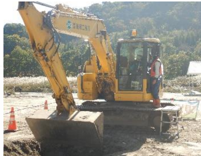
3次元設計データを使ったバックホウ操作
