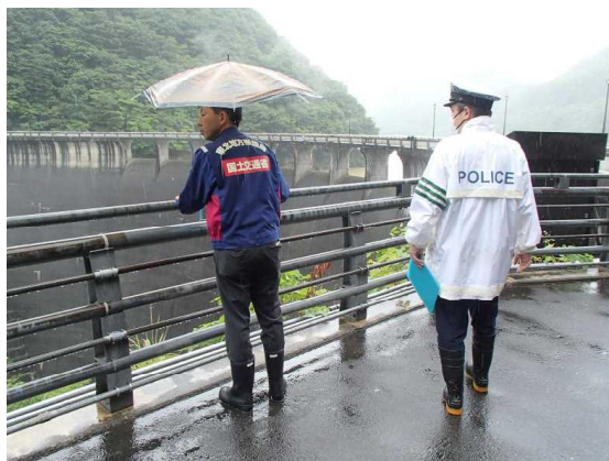
当日の点検状況②
