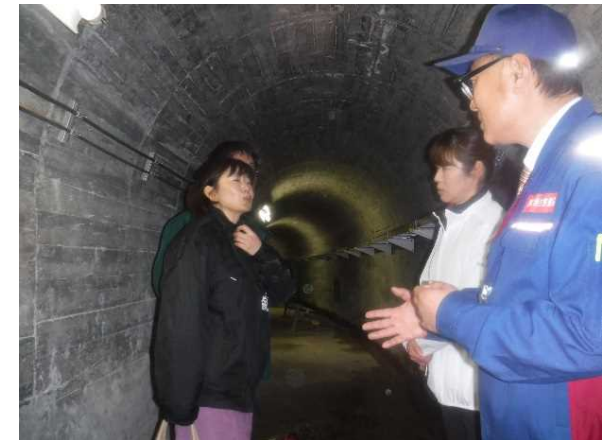
下段監査廊内
