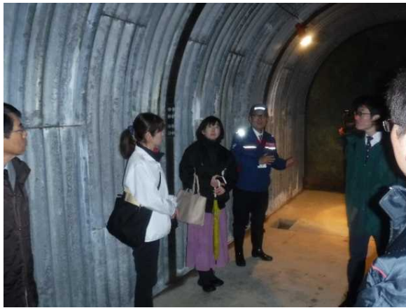
排水トンネル内
