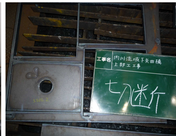
⑥内川流域下矢田橋上部工工事 下矢田橋 鋼橋架設工 材料加工中
