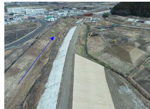
⑫阿武隈川水系内川流域築堤外(その4)工事 新川 河川土工 施工中 〈竹谷橋下流〉
