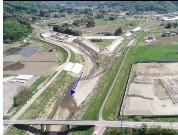
⑭阿武隈川水系内川流域築堤外(その6)工事 内川 河川土工 着手前 〈内川橋上流〉
