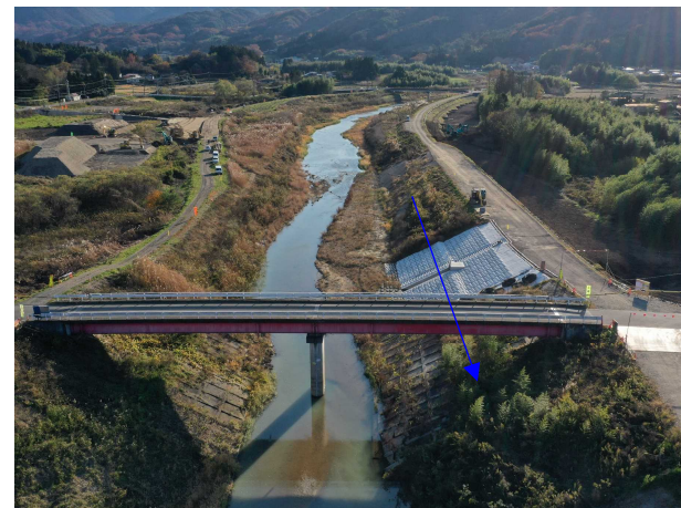
⑱阿武隈川水系内川流域築堤外(その10)工事 樋管⑪ 樋管本体工 着手前 〈大目橋上流〉
