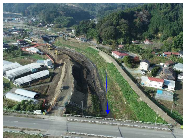
⑰阿武隈川水系内川流域築堤外(その9)工事 五福谷川 仮設工 施工中 〈五福谷橋上流〉
