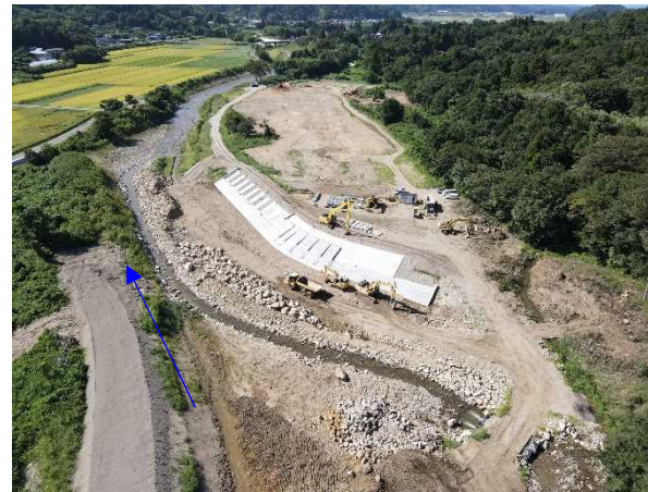
⑪阿武隈川水系内川流域築堤外（その3）工事 内川 法覆護岸工 施工中 〈矢田橋上流〉
