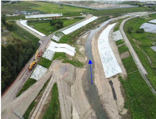
①阿武隈川水系内川流域築堤外工事 内川 法覆護岸工 施工完了 〈大目橋下流〉
