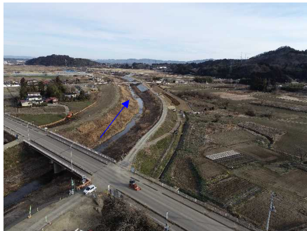
⑳阿武隈川水系内川流域築堤外(その12)工事 五福谷川 河川土工 施工中 〈五福谷川橋下流〉
