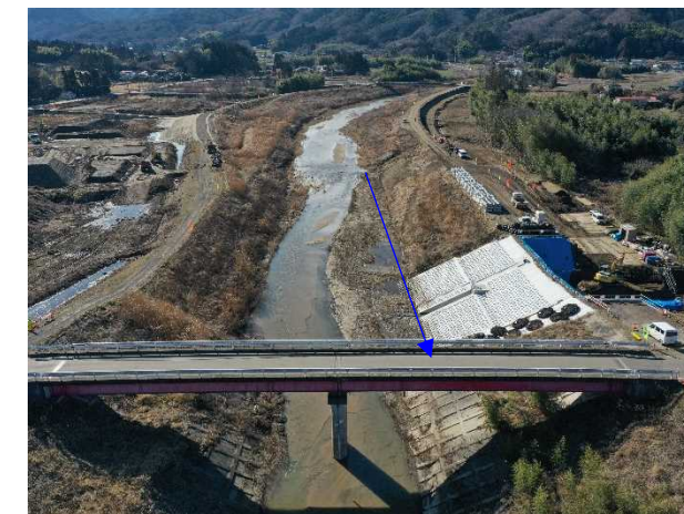
⑱阿武隈川水系内川流域築堤外(その10)工事 樋管⑩ 樋管本体内工 施工中 〈大目橋上流〉
