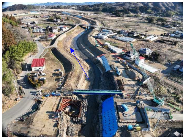
①阿武隈川水系内川流域築堤外工事 五福谷川 河川土工 施工中 〈上地橋上流〉
