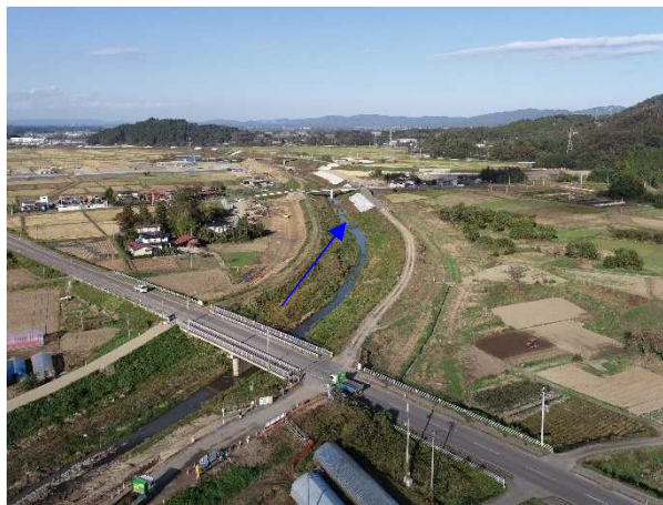
⑳阿武隈川水系内川流域築堤外(その12)工事 五福谷川 河川土工 着手前 〈五福谷川橋下流〉
