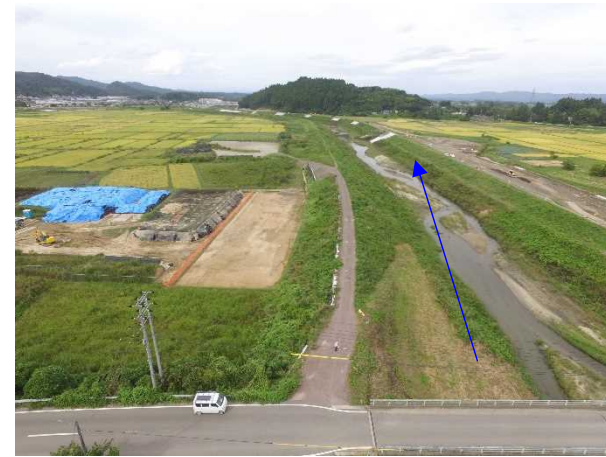
㉑阿武隈川水系内川流域築堤外(その13)工事 内川 河川土工 着手前 〈内川橋下流〉
