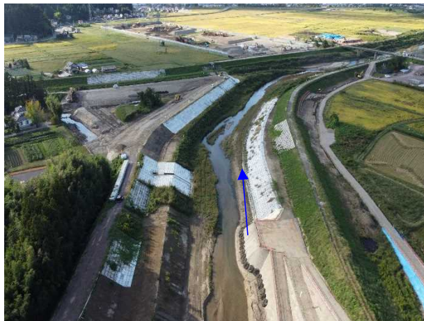
①阿武隈川水系内川流域築堤外工事 内川 河川土工 施工中 〈大目橋下流〉
