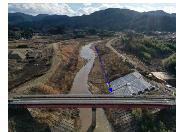
⑱阿武隈川水系内川流域築堤外(その10)工事 樋管⑩ 樋管本体工 施工中 〈大目橋上流〉
