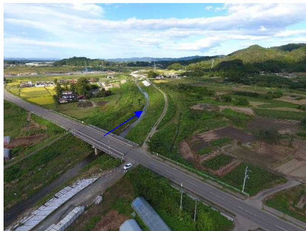
⑳阿武隈川水系内川流域築堤外(その12)工事 五福谷川 河川土工 着手前 〈五福谷川橋下流〉
