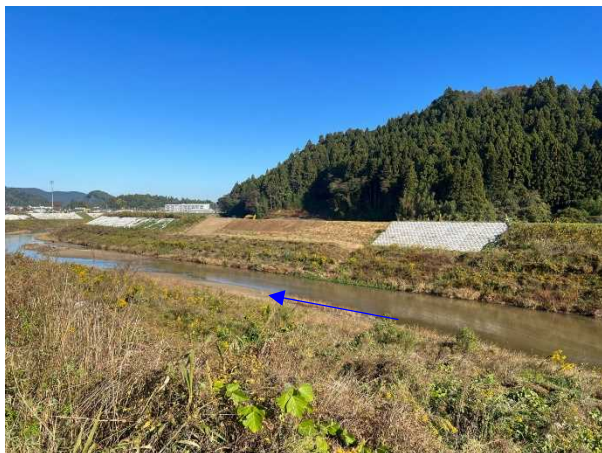
⑦内川流域災害復旧施設外（その2）工事 樋管④ 樋管本体工 着手前 〈内川橋下流〉
