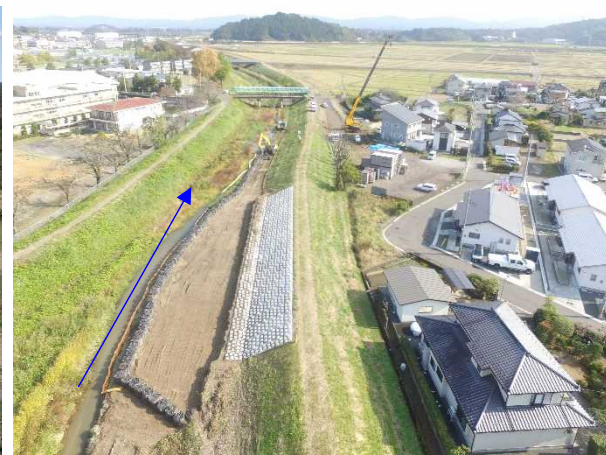
㉑阿武隈川水系内川流域築堤外(その13)工事 新川 河川土工 施工中 〈泉橋上流〉
