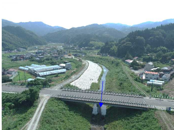
⑰阿武隈川水系内川流域築堤外(その9)工事 五福谷川 着手前 〈五福谷橋上流〉
