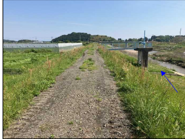
⑧内川流域災害復旧施設外（その3）工事 樋管⑧ 樋管本体工 着手前 〈内川橋上流〉
