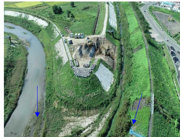
⑨内川流域災害復旧施設外(その4)工事 樋管③ 樋管本体工 着手前 〈内川・新川合流点〉
