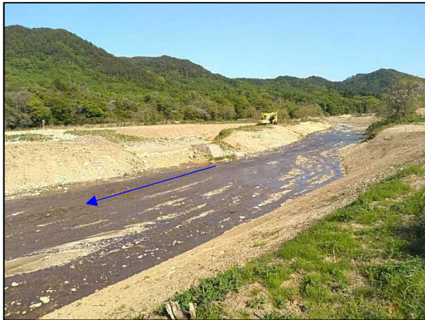
④内川流域橋梁下部工工事 下矢田橋 橋台工 着手前 〈矢田橋上流〉
