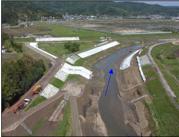
①阿武隈川水系内川流域築堤外工事 内川 法覆護岸工 施工中 〈大目橋下流〉
