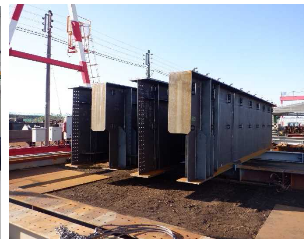
⑥内川流域下矢田橋上部工工事 下矢田橋 鋼橋架設工 組立て状況
