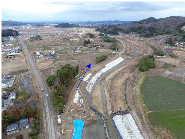
⑱阿武隈川水系内川流域築堤外(その11)工事 内川 河川土工 施工中 〈和田橋下流〉
