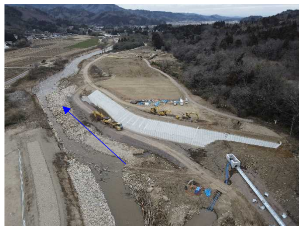
⑪阿武隈川水系内川流域築堤外(その3)工事 内川 法覆護岸工・導水路工 施工中 〈矢田橋上流〉
