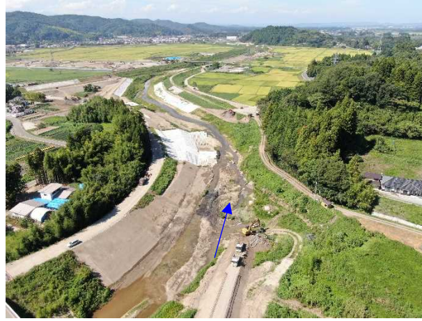
②内川流域山下堰（右岸）工事 山下堰(右岸) 可動堰本體工 着手前 〈大目橋下流〉
