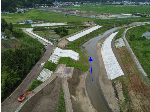
①阿武隈川水系内川流域築堤外工事 内川 河川土工 施工中 〈大目橋下流〉
