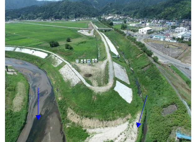
⑨内川流域災害復旧施設外（その4）工事 樋管③ 樋管本体工 着手前 〈内川・新川合流点〉
