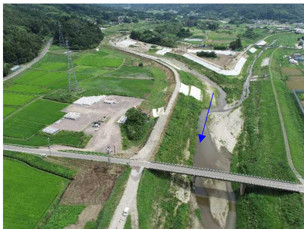
⑯阿武隈川水系内川流域築堤外(その8)工事 内川 着手前 〈内川橋上流〉
