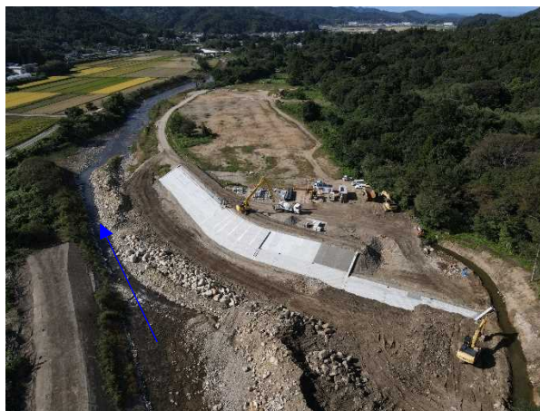
⑪阿武隈川水系内川流域築堤外(その3)工事 内川 法覆護岸工・導水路工 施工中 〈矢田橋上流〉
