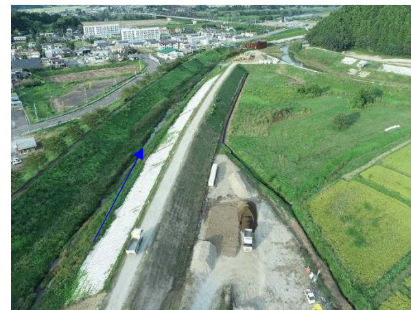
⑫阿武隈川水系内川流域築堤外(その4)工事 新川 河川土工 着手前 〈竹谷橋下流〉
