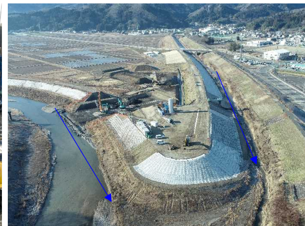
⑨内川流域災害復旧施設外(その4)工事 樋管③ 樋管本体工 施工中 〈内川・新川合流点〉
