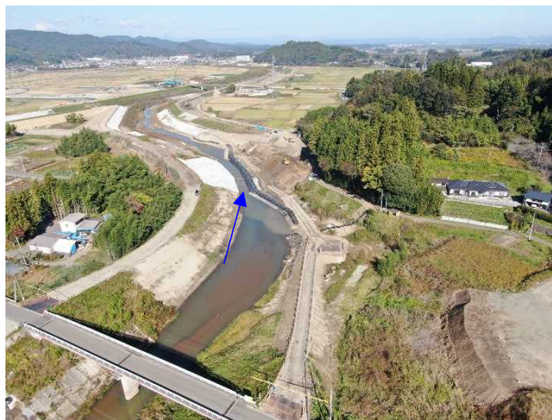
②内川流域山下堰（右岸）工事 山下堰(右岸) 仮設工 施工中 〈大目橋下流〉
