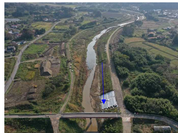
⑱阿武隈川水系内川流域築堤外(その10)工事 樋管⑩ 樋管本体工 着手前 〈大目橋上流〉
