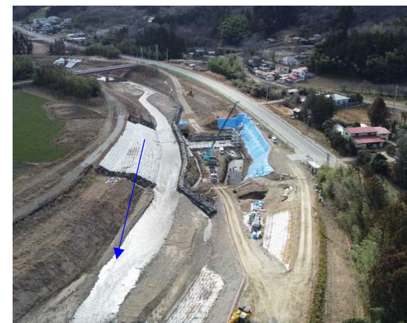
③内川流域和田堰（左岸）工事 和田堰(左岸) 構造物撤去工 施工中 〈和田橋下流〉
