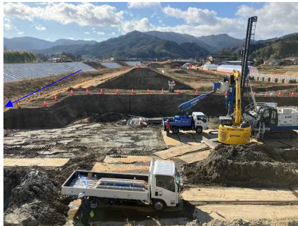
⑧内川流域災害復旧施設外(その3)工事 樋管⑧ 樋管本体工 施工中 〈内川橋上流〉
