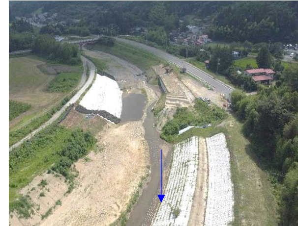
③内川流域和田堰（左岸）工事 和田堰(左岸) 可動堰本體工 着手前 〈和田橋下流〉
