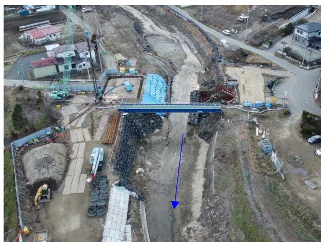
④内川流域橋梁下部工工事 旧五福谷橋 旧橋撤去工 施工中 〈旧五福谷橋上流〉
