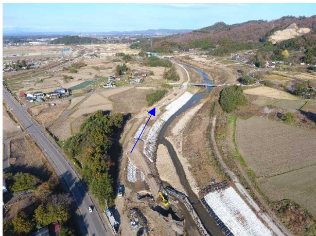
⑱阿武隈川水系内川流域築堤外(その11)工事 内川 河川土工 着手前 〈和田橋下流〉
