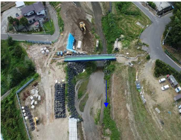
④内川流域橋梁下部工工事 旧五福谷橋 旧橋撤去工 施工中 〈旧五福谷橋上流〉
