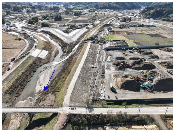
⑭阿武隈川水系内川流域築堤外(その6)工事 内川 河川土工 施工中 〈内川橋上流〉
