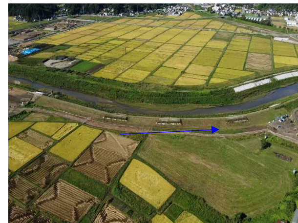
⑮阿武隈川水系内川流域築堤外(その7)工事 内川 河川土工 着手前 〈内川橋下流〉
