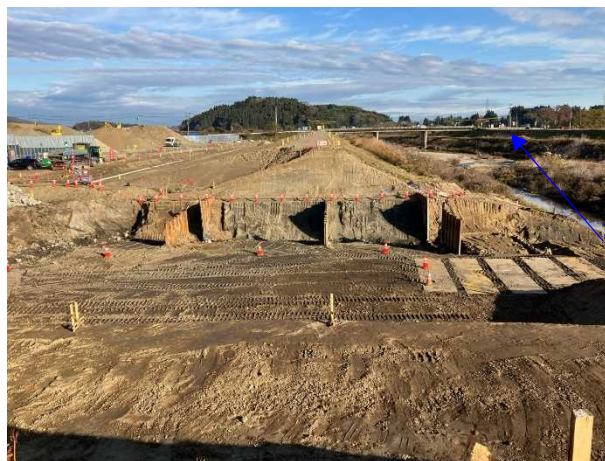
⑧内川流域災害復旧施設外(その3) 工事 樋管⑧ 樋管本体工 施工中 〈内川橋上流〉
