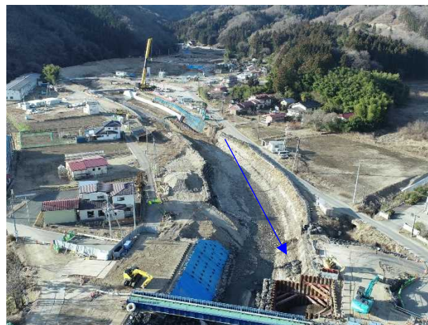
⑰阿武隈川水系内川流域築堤外(その9)工事 五福谷川 ブロック積 施工中 〈旧五福谷橋上流〉
