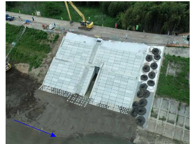
⑫阿武隈川水系内川流域築堤外(その4)工事 樋管⑪ 法覆護岸工 施工中 〈大目橋上流〉
