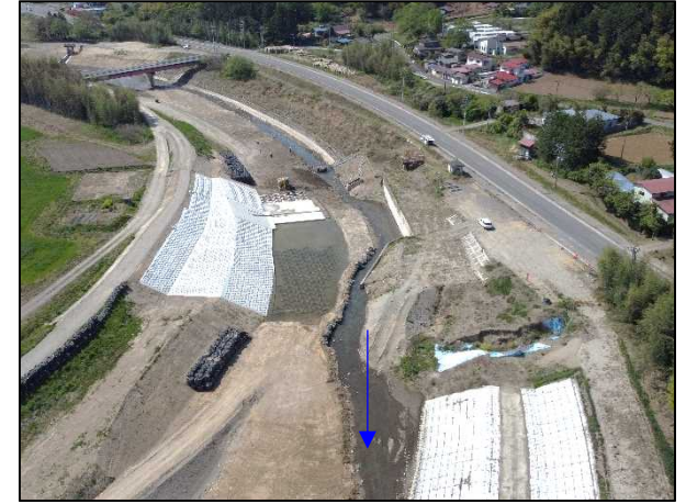
③内川流域和田堰（左岸）工事 和田堰(左岸) 可動堰本体工 着手前 〈和田橋下流〉
