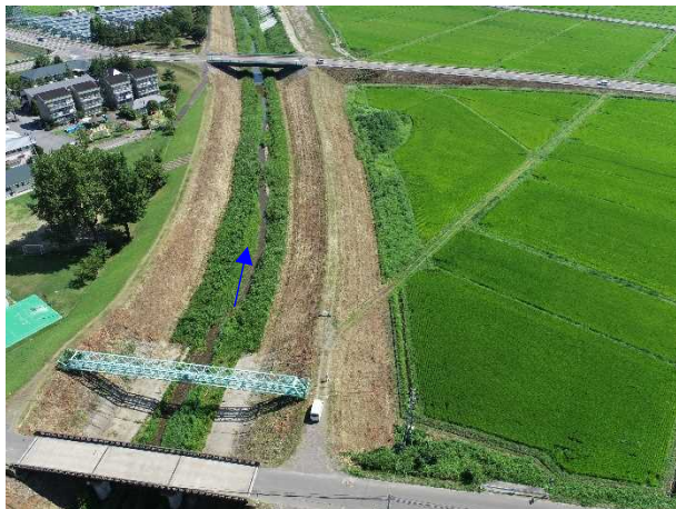
⑬阿武隈川水系内川流域築堤外(その5)工事 新川 河川土工 着手前 〈泉橋下流〉
