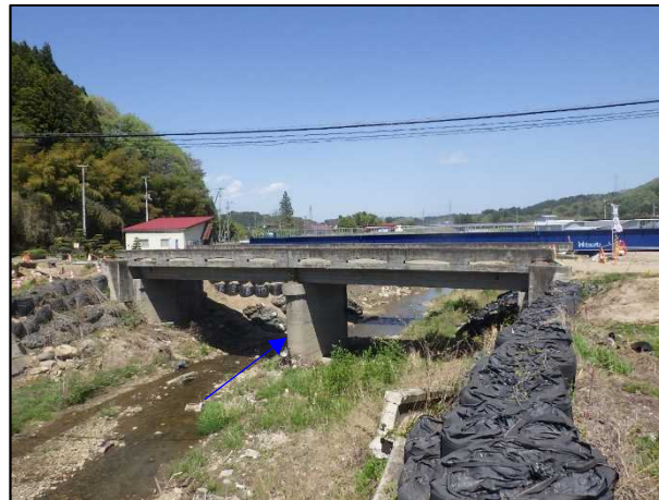
⑤内川流域五福谷橋上部工工事 旧五福谷橋 PC橋工 着手前 〈旧五福谷橋〉
