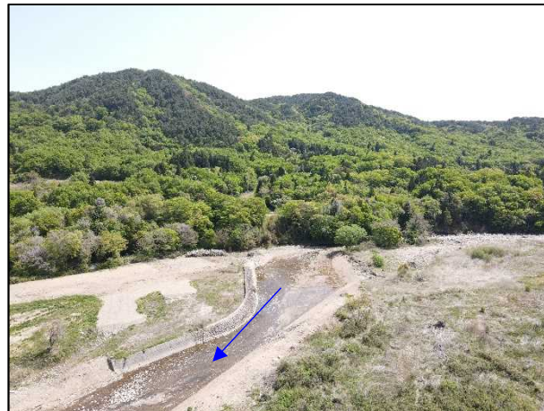
⑪阿武隈川水系内川流域築堤外(その3)工事 内川 法覆護岸工 着工前 〈矢田橋上流〉
