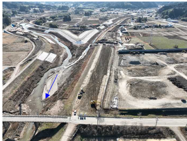
⑭阿武隈川水系内川流域築堤外(その6)工事 内川 河川土工 施工中 〈内川橋上流〉
