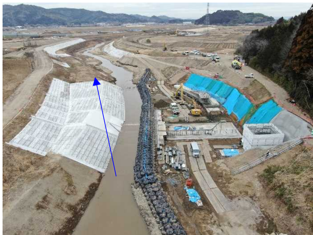
②内川流域山下堰（右岸）工事 山下堰(右岸) 仮設工 施工中 〈大目橋下流〉
