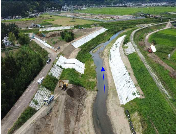
①阿武隈川水系内川流域築堤外工事 内川 河川土工 施工中 〈大目橋下流〉
