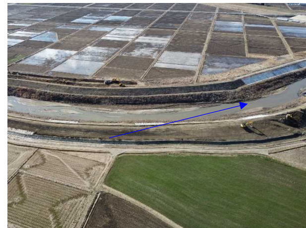
⑮阿武隈川水系内川流域築堤外(その7)工事 内川 河川土工 施工中 〈内川橋下流〉
