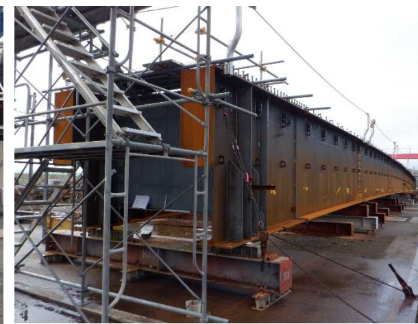
⑥内川流域下矢田橋上部工工事 下矢田橋 鋼橋架設工 仮組立て完了
