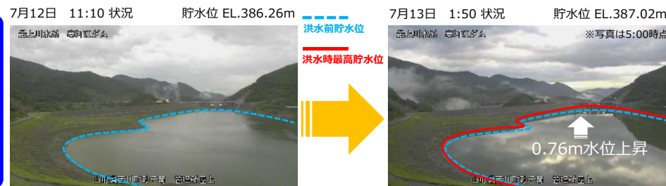
寒河江ダム貯水状況
