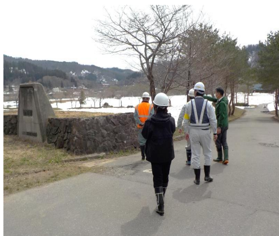
白川ダムの点検状況(湖岸公園)
