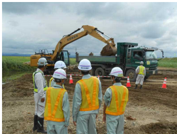
河川工事現場見学
