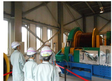
長井ダム堤体巡視体験
