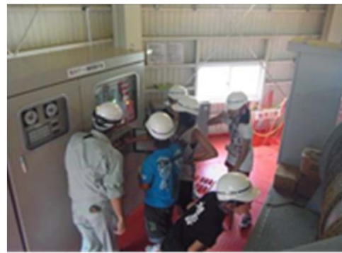
(取水設備の点検)
