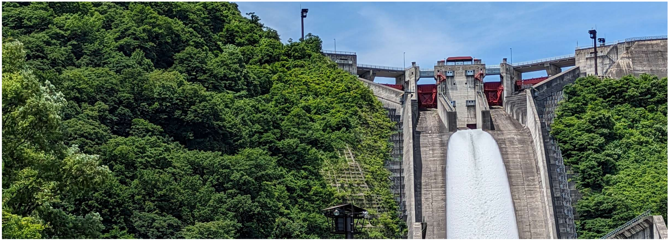
「ゲートからのフラッシュ放流」 寒河江ダム
