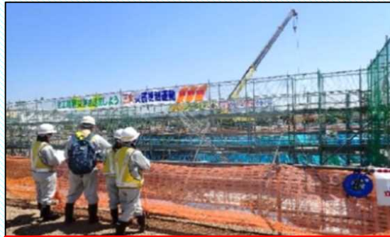
施工箇所(ボックスカルバート)の点検
