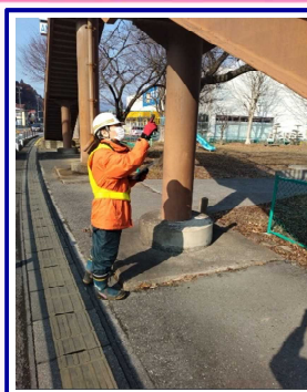
▲ 歩道橋の点検
