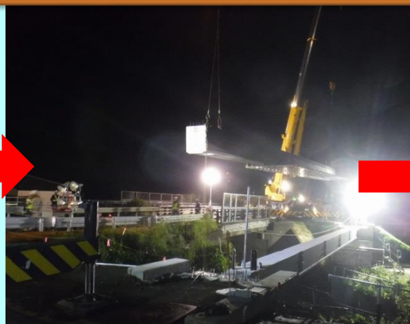
▲ 橋桁設置作業(令和4年6月8日)
