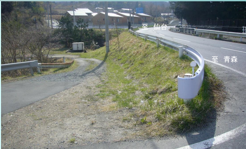
▲ 着工前(平成31年4月23日)
