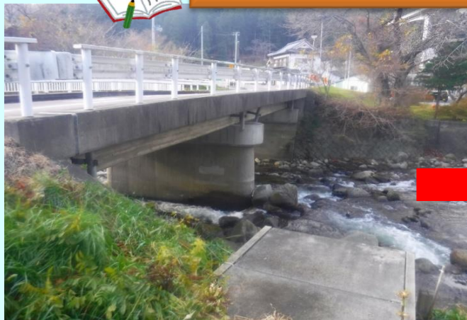
▲ 橋桁設置前(令和3年11月26日)
