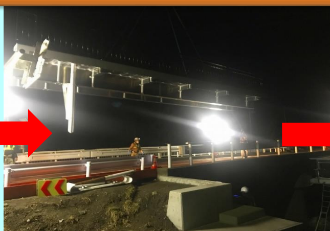
▲ 橋桁設置作業(令和4年3月16日)
