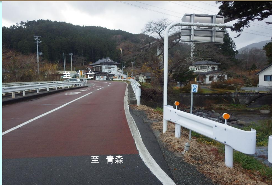
▲ 着工前(令和3年11月25日)
