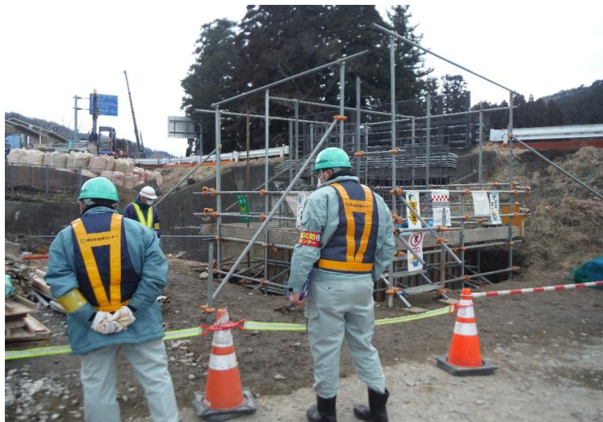
▲ 工事が適切に実施されているか、各工事管理者、出張所監督担当者、事務所事故防止委員、建災防と点検を行いました。
