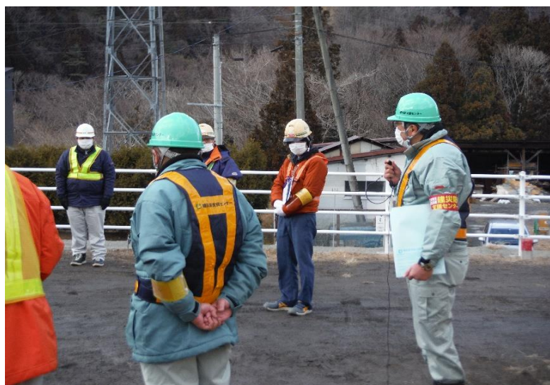
◀ 点検後、建災防より安全巡回指導をいただきました。工事事故の事例や工事において注意すべき点等の講話を頂きました。今後も事故のないよう安全に気をつけて工事を実施して参ります。
