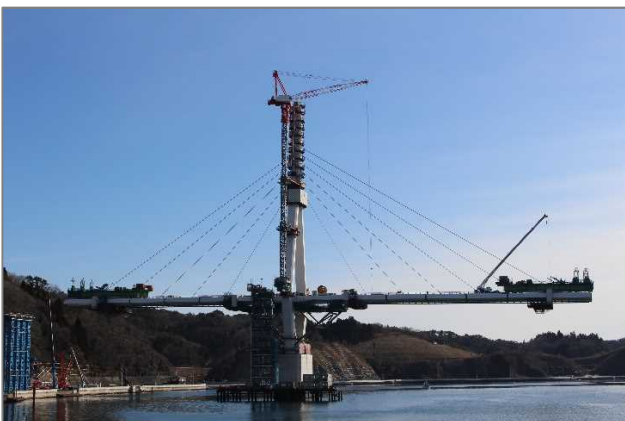
▲バランシング架設
