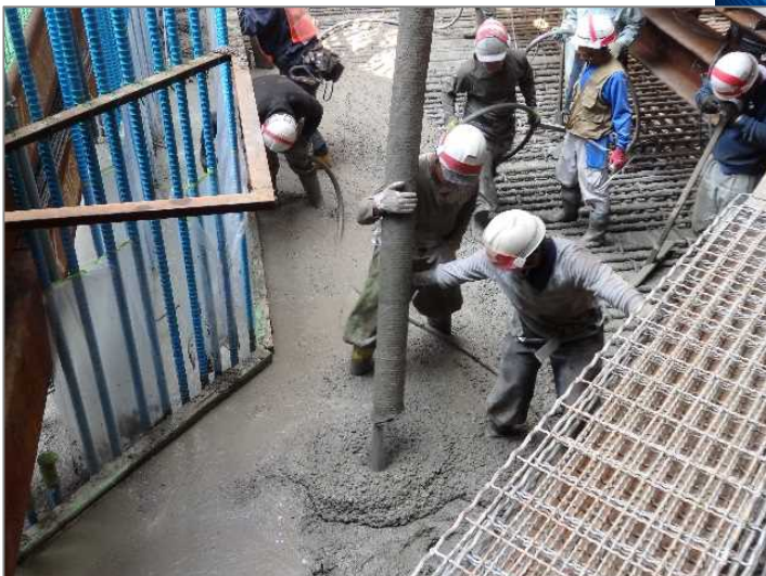
▼コンクリートを流し込む様子
