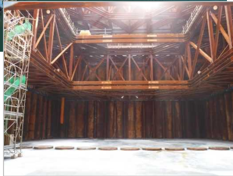
▲ドライアップ(水抜き)完了
