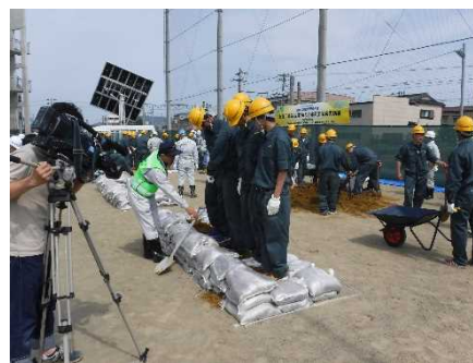
▲中詰め土を締め固める様子
