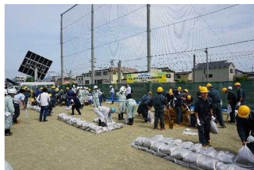
▲積土のう工の全体状況
