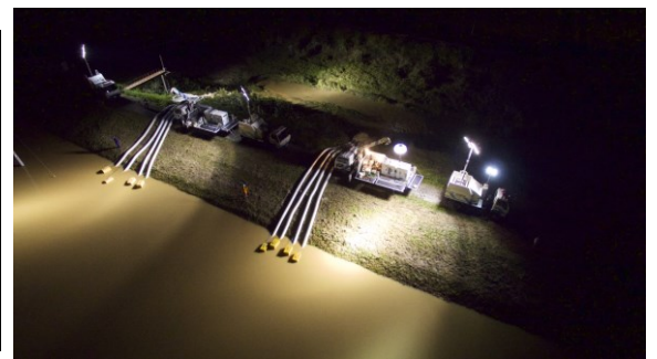
二迫川排水状況（H27.9洪水）
