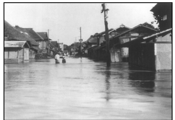
昭和22年9月カスリン台風洪水の広範囲で長期の浸水となった登米市中田町付近
