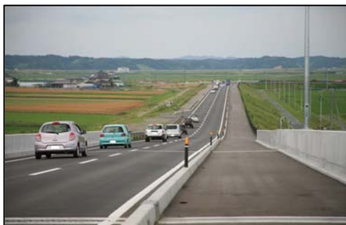
二線堤整備状況
