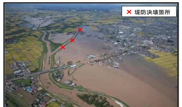
平成27年9月関東・東北豪雨で 3箇所堤防が決壊した洪井川
