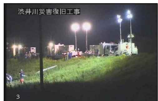
照明車設置による24時間復旧工事
