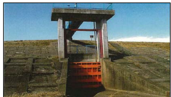
非常用排水樋管（内浦排水樋管）
