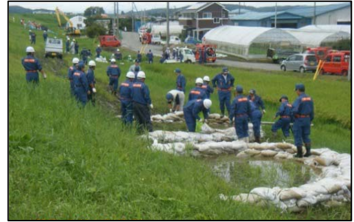
吉田川での水防活動（月の輪工）
