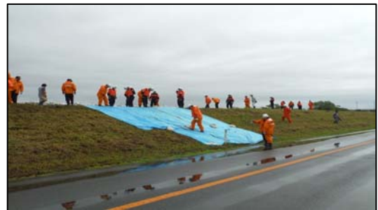
江合川での水防活動（シート張り）
