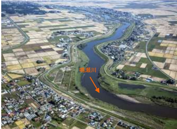
鳴瀬川中流部築堤箇所（11.5km 付近）
