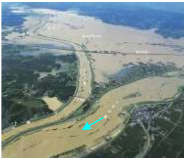
吉田川旧鹿島台（大崎市）の堤防決壊により浸水
