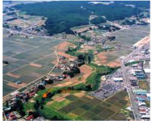
吉田川上流地区河道掘削箇所（31.1km 付近）
