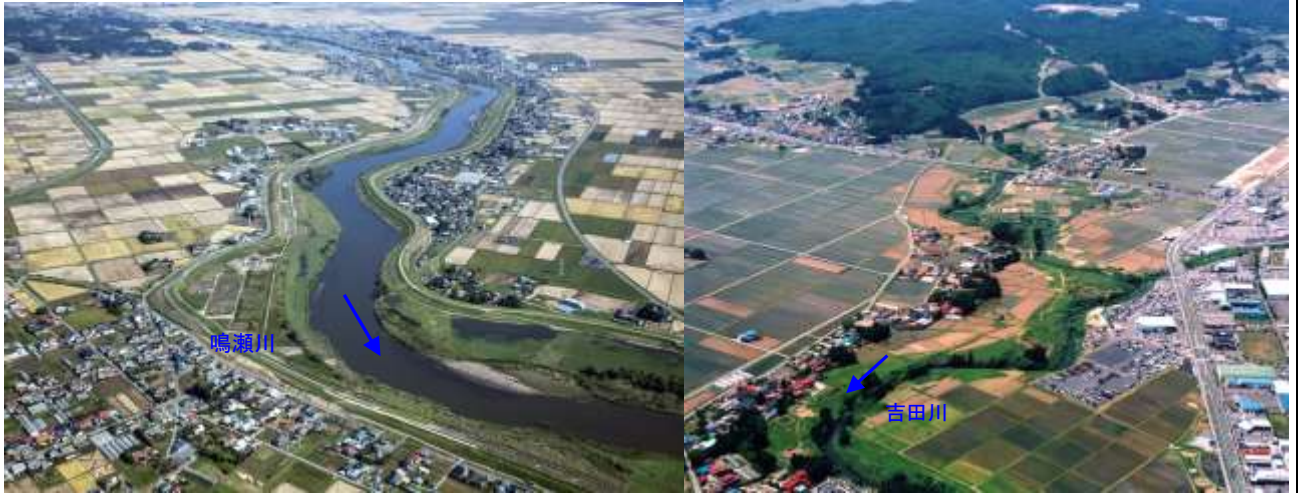
鳴瀬川中流部の築堤状況（左岸 11.5km 付近） 吉田川上流地区の河道掘削状況（31.1km 付近）
