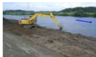
河道掘削状況
