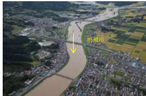
鳴瀬川 三本木橋付近
