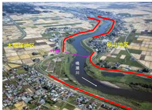
鳴瀬川中流部（11.5k付近）
