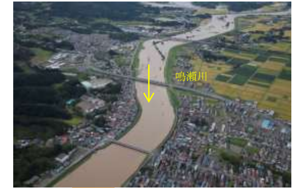
平成27年9月洪水 鳴瀬川三本木橋付近
