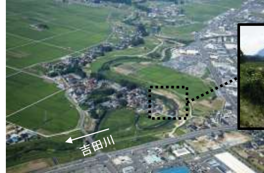
河道掘削状況(吉田川上流)
