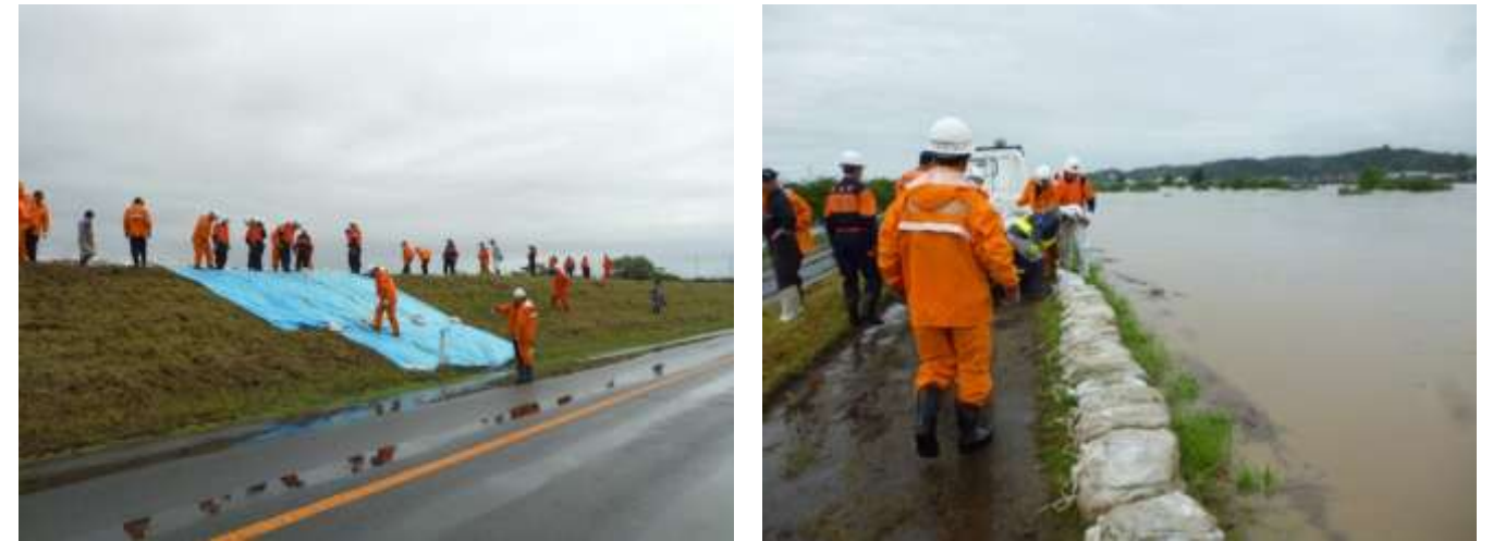
土のう積み工法により堤防の 越水を防止
