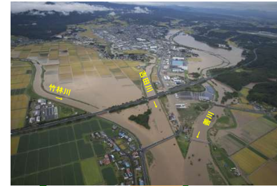
平成27年9月洪水 吉田川落合橋付近
