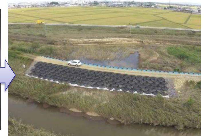
護岸での補強を完了した中流工区の堤防
