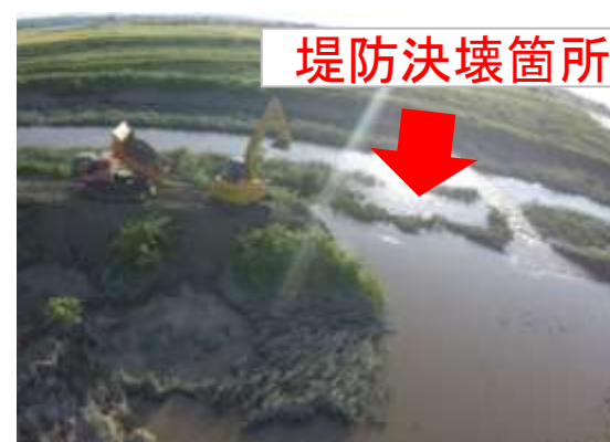
下流工区で堤防盛立に着手
