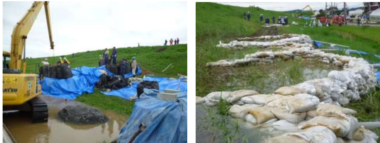
建設業者の重機を活用した月の輪工法による漏水対策を実施
