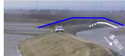
築堤利用(多田川)
