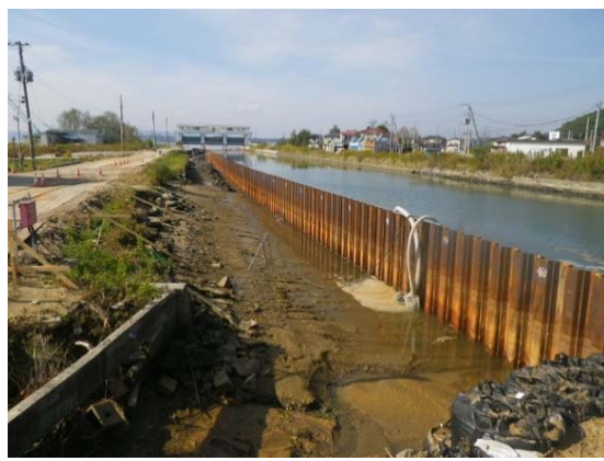
①仮締切工(左岸:H26.11月)
