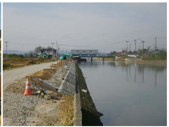
②継足し護岸工(左岸:H26.11月)
