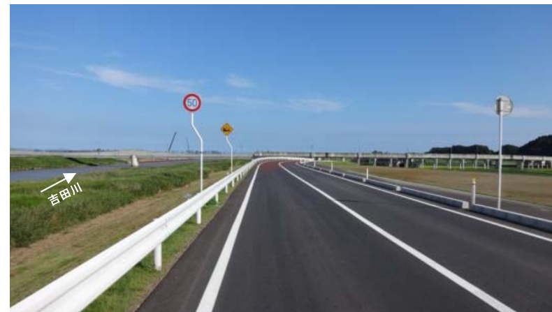
兼用復旧状況 (右岸2.0km付近:H25.11月)
