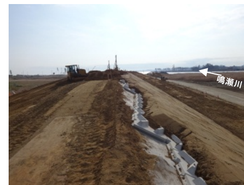
堤防復旧状況 (左岸：0.8km付近:H25.12月)
