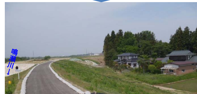
復旧完了後(H25.6月撮影)鳴瀬川下中ノ目地区
