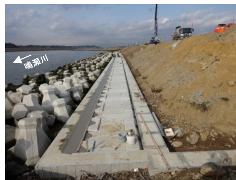
堤防復旧状況 (左岸：0.2km付近:H25.12月)
