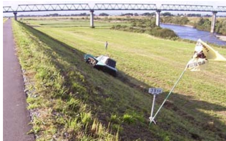
堤防除草の状況（鳴瀬川）
