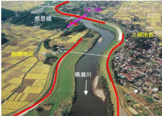
鳴瀬川中流部築堤箇所（16.9km 付近）
