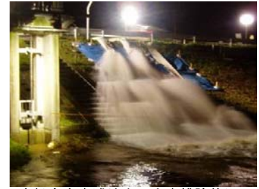
東松島市宿浦地内の内水排除状況 (平成 18 年 10 月洪水)
