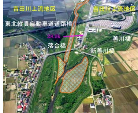
吉田川上流地区河道掘削箇所（28.9km 付近）
