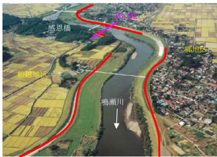
鳴瀬川中流部（16.9k付近）
