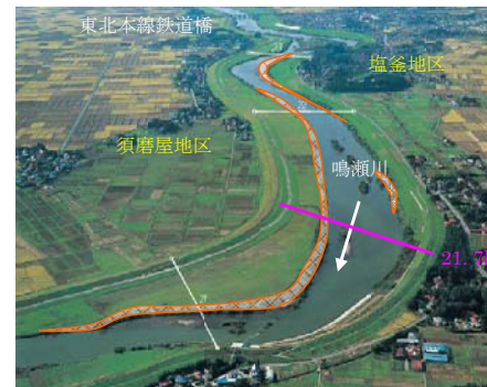
鳴瀬川中流部（21.3k付近）
