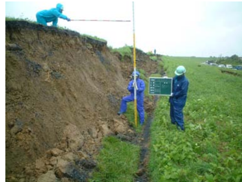
鳴瀬川右岸13.0k付近(大崎市木間塚) ※地震による堤防沈下
