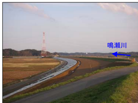
築堤(鳴瀬川左岸8.0k付近)
