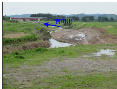
河道掘削(吉田川29.7k付近)
