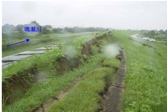
鳴瀬川右岸13.0k付近(大崎市木間塚) ※地震による堤防沈下
