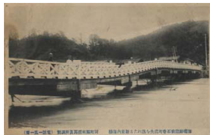
中瀬東岸より撮影、海嘯のため明治44年竣工の東内海橋は鋼管パイプ橋脚2組が波打つ被害を受けた
