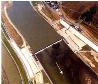
鳴瀬堰(鳴瀬川)
