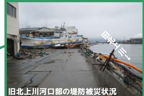
鳴瀬川河口部の堤防被災状況
