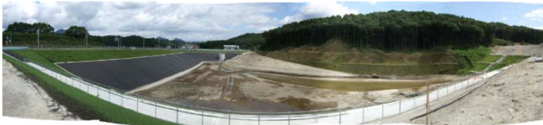
防災調整池(都)荒巻大和町線から調節池を望む
