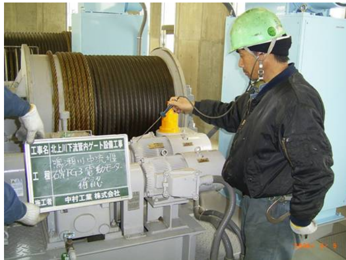
堰ゲートの点検状況（鳴瀬川中流堰）
