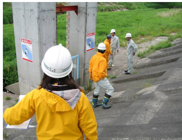
吉田川流域下水道排水樋管(許可工作物)の点検 (H20. 5. 8)
