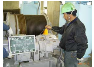
河川管理施設の点検
