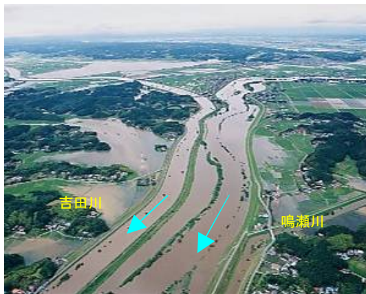
鳴瀬川・吉田川 鹿島台観測所付近
