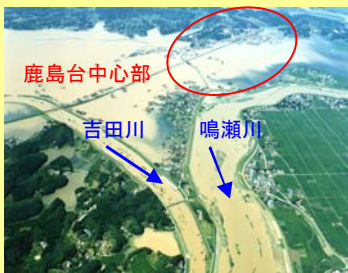
吉田川破堤に伴う浸水状況(S61.8洪水)
