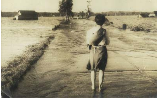
鳴瀬川旧三本木（大崎市）奥州街道沿いの橋梁が水没
