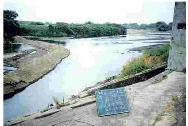
鳴瀬川小牛田町水道
