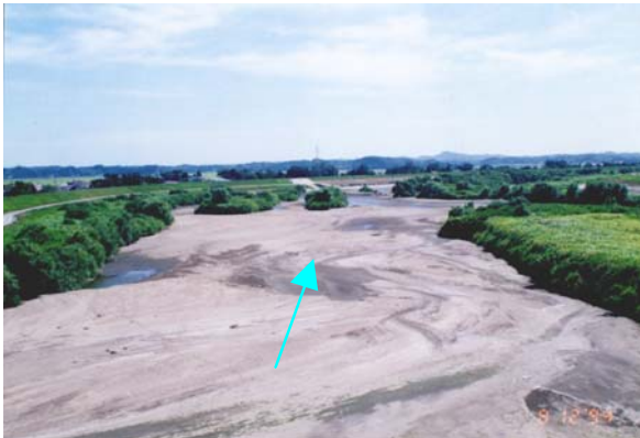
木間塚大橋下流の瀬切れ状況
