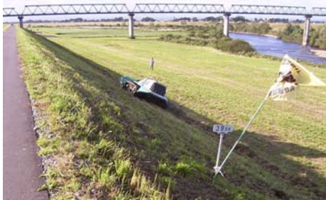
堤防除草の状況（鳴瀬川）
